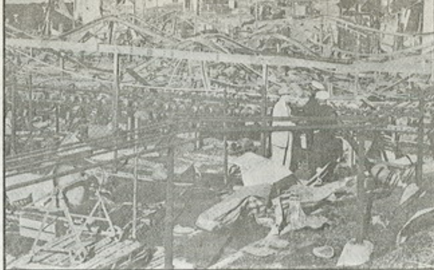
Ό,τι απέμεινε μετά από έκρηξη και πυρκαγιά σ' ένα εργοστάσιο αναγόμωσης φιαλών ασετυλίνης στο Λος Άντζελες.
